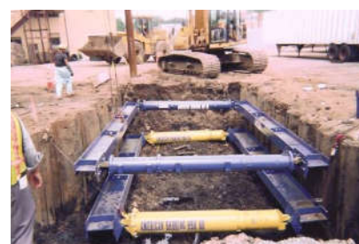
Sistemas Hidráulicos de sustentação De Escavações
