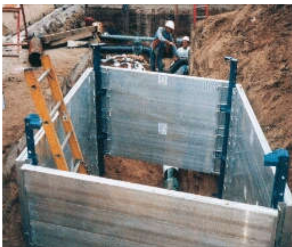
Entivação Com Painéis e Prumos Metálicos
