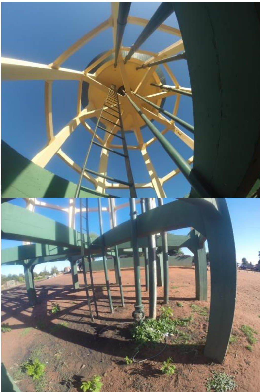
Figura 3: Reservatório elevado de Combomune Estação
