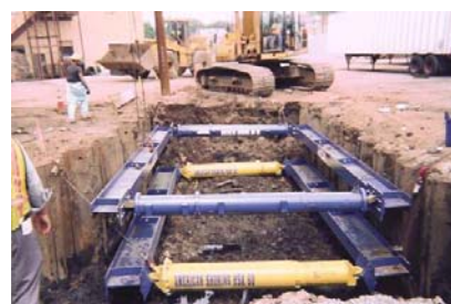
Sistemas Hidráulicos de sustentação De Escavações
