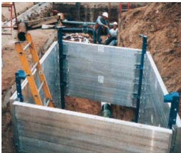
Entivação Com Painéis e Prumos Metálicos
